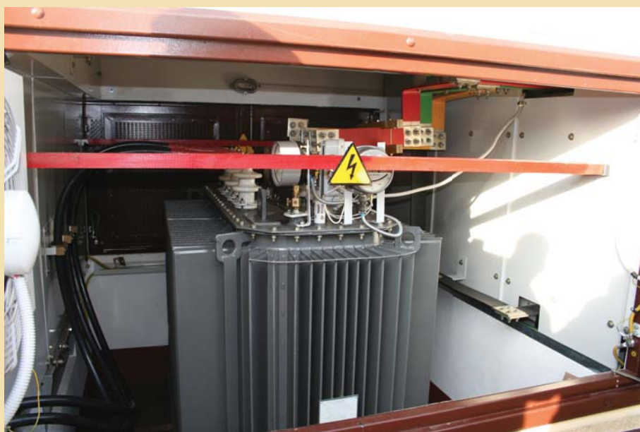
Отсек трансформатора
