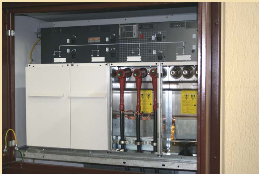
Отсек распределительного устройства высшего напряжения (УВН)
